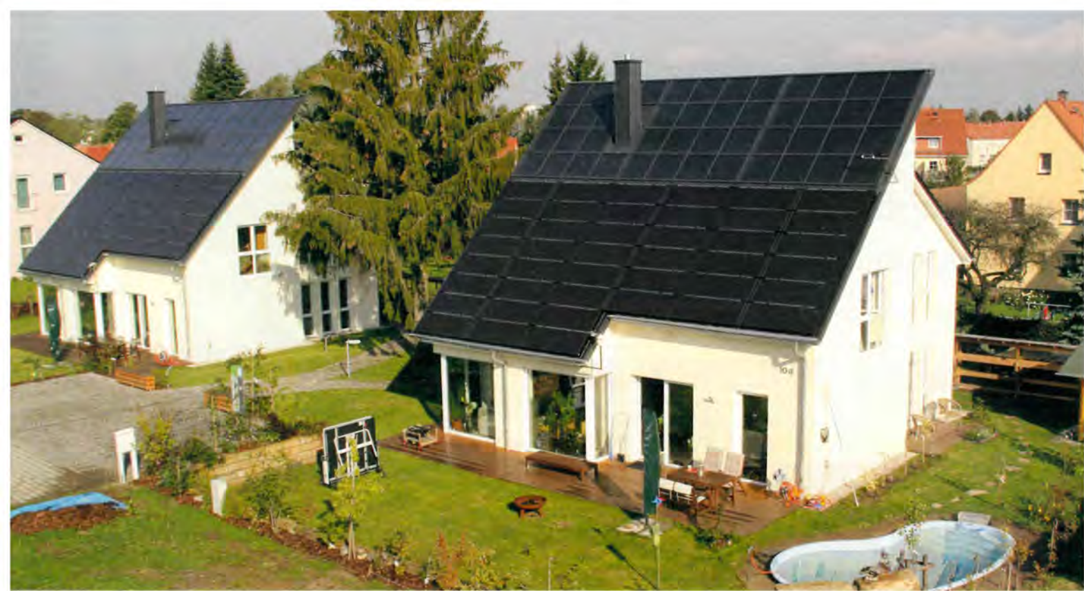
Zwillingsbauten: Zu Testzwecken hat Timo Leukefeld im sächsischen Freiberg zwei identische Häuser errichtet, ein Wohnhaus für seine Familie und einen Sitz für sein Planungsbüro. Beide Gebäude sind so konzipiert, dass sie ihren Wärmebedarf zu 70 Prozent und ihren Strombedarf fast zu 100 Prozent mit Sonnenenergie decken.
